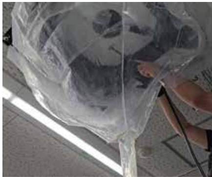
写真2 内部洗浄（アップ）
