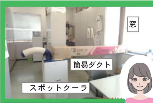
冷房の効きが悪い部屋では、スポットクーラーを設置。効率を図るために、排熱を廃材利用の簡易ダクトに流し、窓に排出させるなど、ちょっとした工夫が、お客さまから、たいへん喜ばれました。
