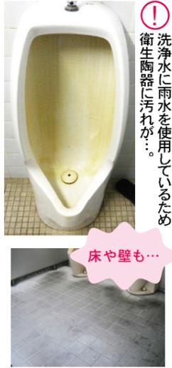
! 洗浄水に雨水を使用しているため衛生菌等に汚れます。
